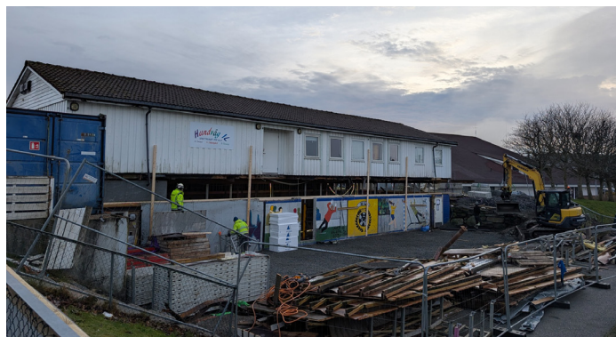
2. etasje ble hevet nesten 1 meter for å oppnå tilstrekkelig takhøyde i underetasjen. Her midt i prosessen, da huset stod på jekker i kjelleren.
