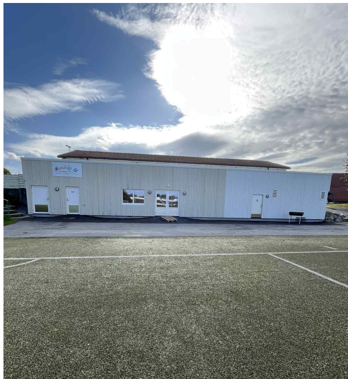
Den nye fasaden er lekker, nå gjenstår en maledugnad for å få prikken over i-en.
